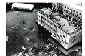
西淀中学校舎の屋上へ避難する人々
