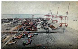
神戸港 空コンテナ移動状況
