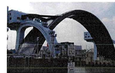
3大水門(1970年完成) 【建設後48年が経過】
