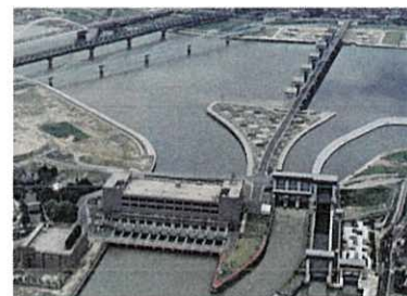
毛馬排水機場(1981年完成) 【建設後37年が経過】
