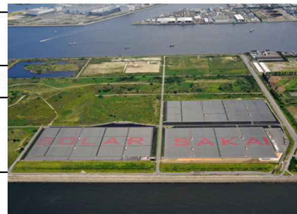
関西電力・堺 太陽光発電所
